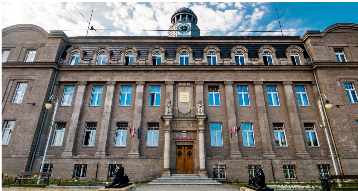
Budynek Ratusza Urzędu Miejskiego w Zabrze przy ul. Religii
