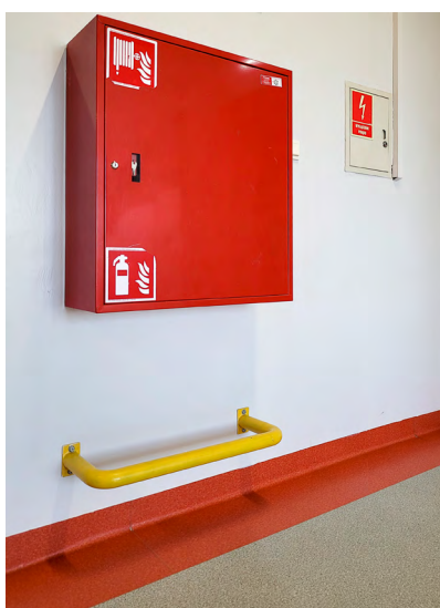
Ilustracja 56. Przykłady zabezpieczenia elementów wystających przed lico ściany na odległość większą niż 0,1 m. Na zdjęciu po lewej przykład zastosowania poprzeczki, pośrodku przykład obudowy gabloty, po prawej zabezpieczenie gabloty z zastosowaniem ciężkich donic, fot. Katarzyna Guratowska
