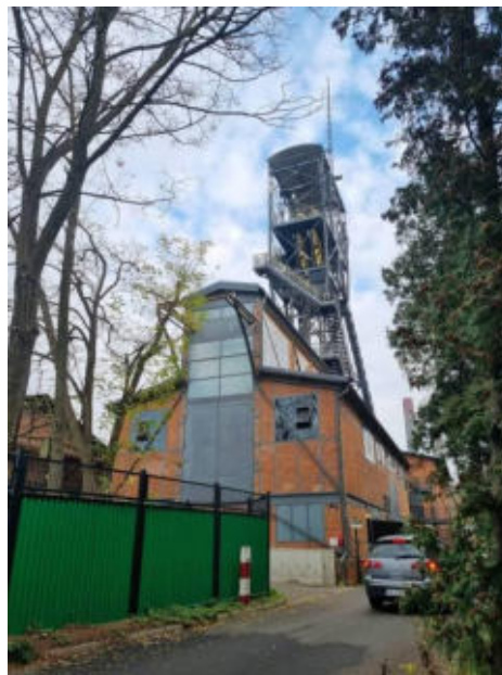
Fotografia 14. Fragment zabudowy dawnej kopalni „Królowa Luiza”
