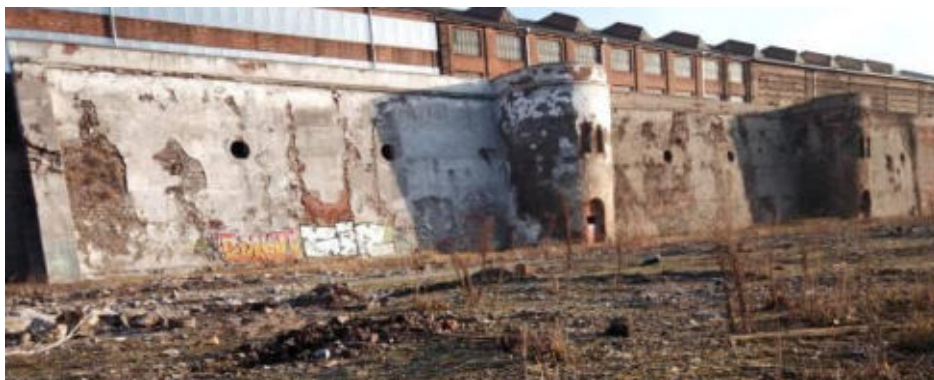
Fotografia 18. Fragmentu muru oporowego w obrębie Huty Zabrze
