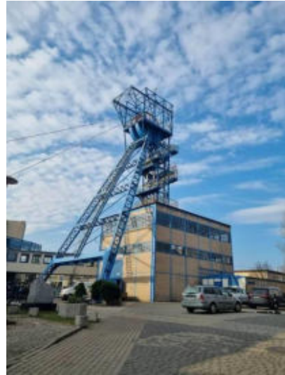
Fotografia 15. Fragment zabudowań nadziemnych kopalni „Guido”
