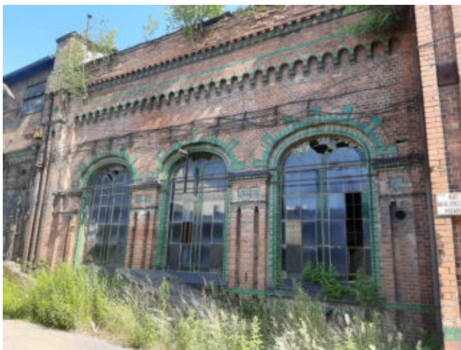
Fotografia 22. Budynek siłowni energetycznej
