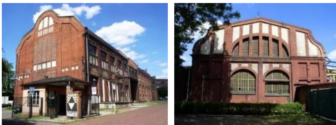
Zespół zabudowy kopalni Ludwik przy ul. Hagera, budynki szatni i łaźni oraz ślusarni i kuźni
