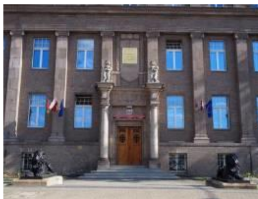
Środkowe osie fasady z wejściem głównym
