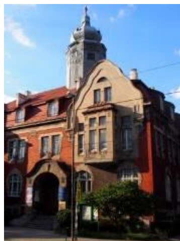
Wschodnia część budynku
